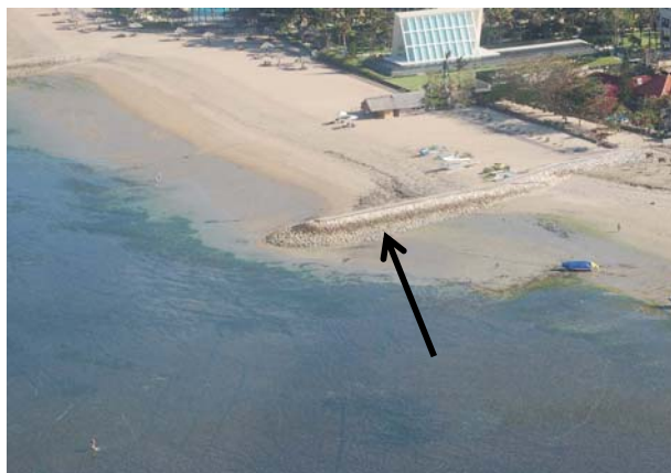
Kerusakan padang lamun oleh Groin di Pantai Nusa Dua
